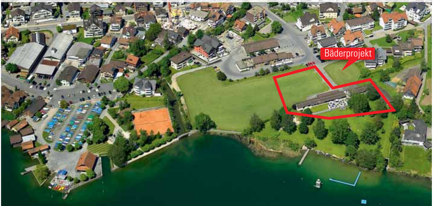
Der Standort für das «Bäderprojekt Ägerital»: Die rote Markierung umrahmt das Areal für die geplante Anlage. Im östlichen Teil davon ist der neue Tennisplatz vorgesehen.
