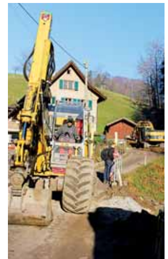
Mitteldorfbach: Schwere Baumaschinen kommen für die Sanierung zum Einsatz.
