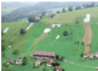
Unwetter: Spendengelder hal- fen Schäden zu beheben.
