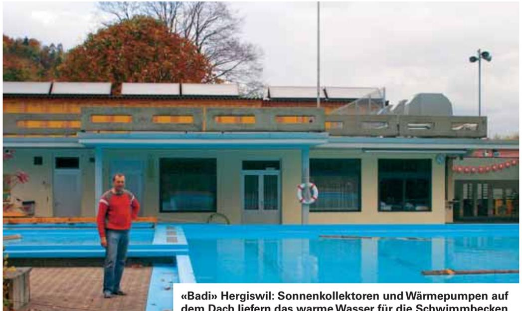
«Badi» Hergiswil: Sonnenkollektoren und Wärmepumpen auf dem Dach liefern das warme Wasser für die Schwimmbecken.
