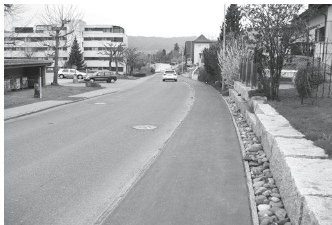
Mitteldorfstrasse in Richtung Hauptstrasse
