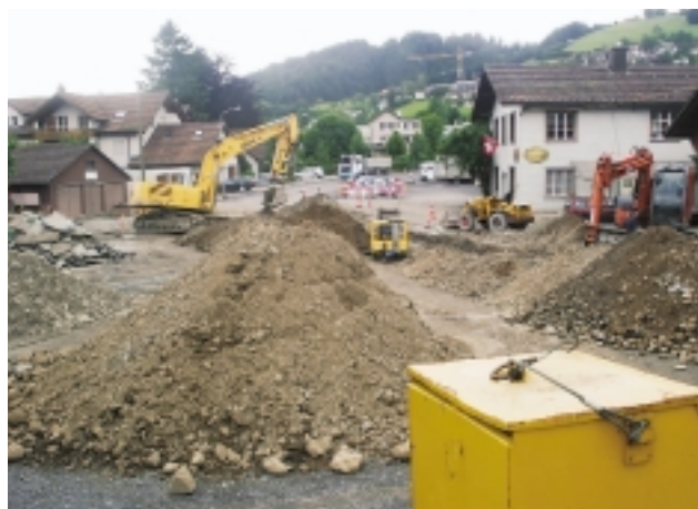
Seeplatzsanierung: Wo anfangs Juni noch gebaggert wurde, wachsen bald Bäume Himmel.
